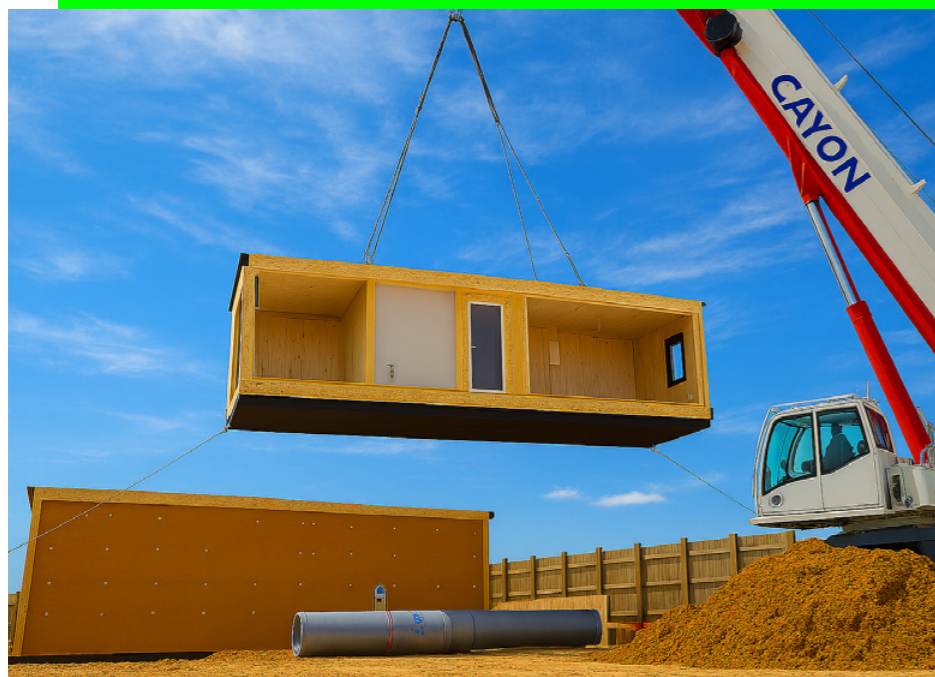
Construction à Chevannes de 10 maisons modulaires bois, biosourcées et économes en énergie – Livraison prévue en juin 2026
