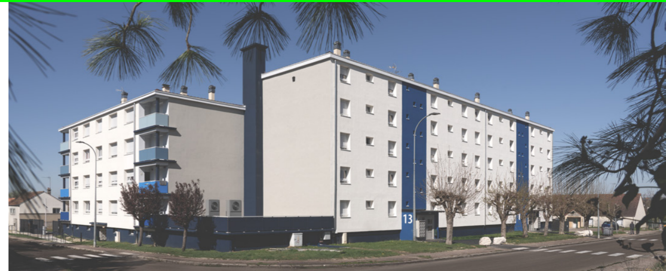
Éco-rénovation à Cheny - 42 appartements
